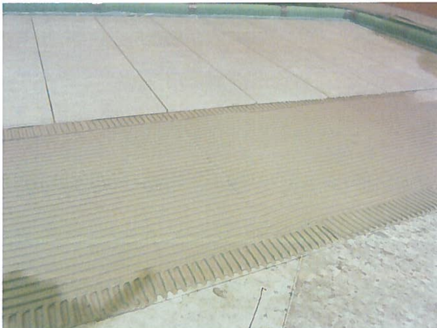
Kuva 4. Keraamisen laatan asennus
