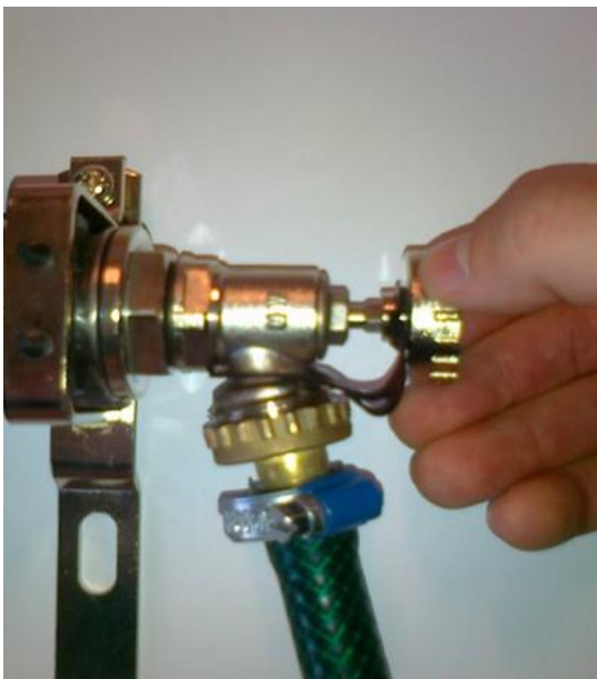
Kuva 7. Venttiilin sulkeminen
