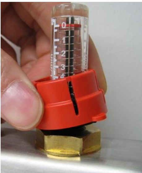
Kuva 3. Virtausmittarin lukitusosan poisto
